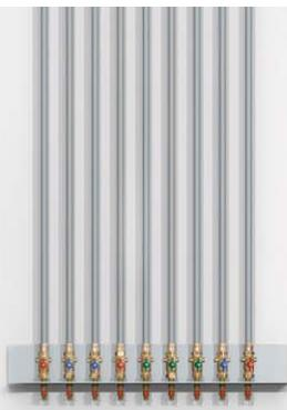
Im Heizungskeller laufen alle Rohrleitungen zusammen. Die Rohre in diesem Bild werden in der Vormontageleiste gebündelt. Nach dem Befüllen, Spülen inkl. Druckprüfung folgt Schritt 2:
