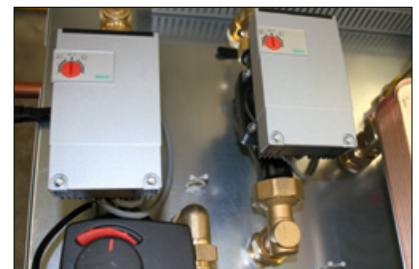
Hocheffizienz-Umwälzpumpen Energieklasse „A“
